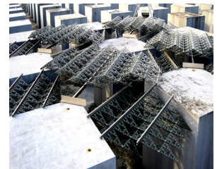
Fig.2 日除け設置の状況
