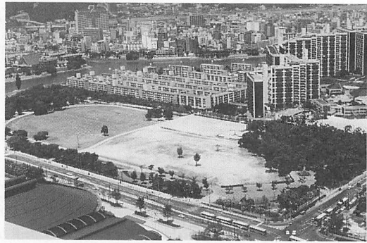
写真1. 熱画像測定点からみた観測サイトの俯瞰
