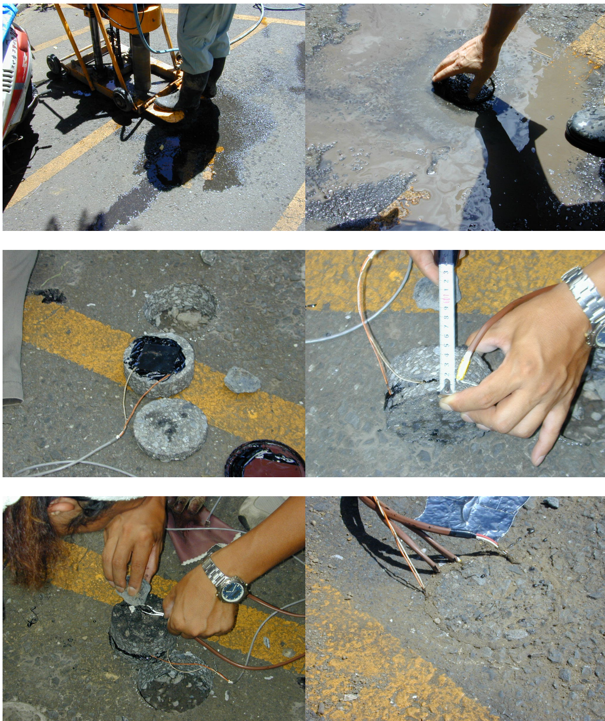
写真 3－3 アスファルト舗装面のコア抜きとセンサーの設置状況
